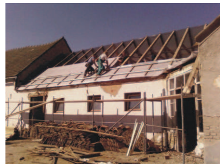
Az alsó tagozat épületének tetőcseréje
